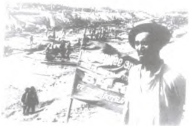
Строительство Большого Чуйского канала.
