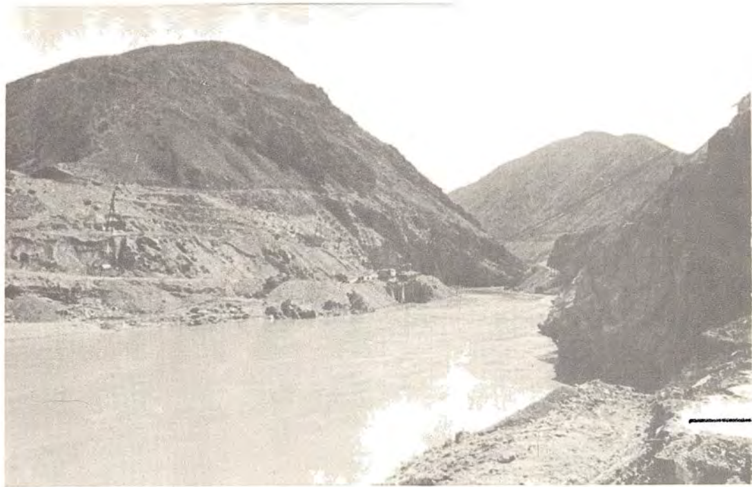
Строительство Камбаратинской ГЭС.
